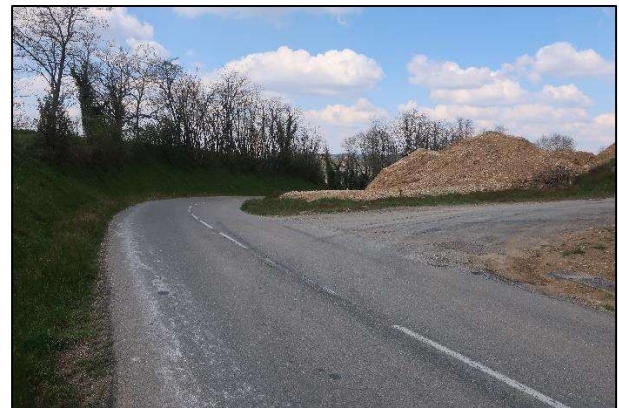
Accès au chemin d'exploitation depuis la RD 130 A et travaux de talutage réalisés Source : ARTIFEX 2022
