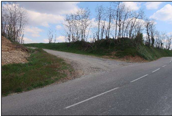
Accès au chemin d'exploitation menant à l'unité, depuis la RD 130 A Source : ARIFEX 2022
